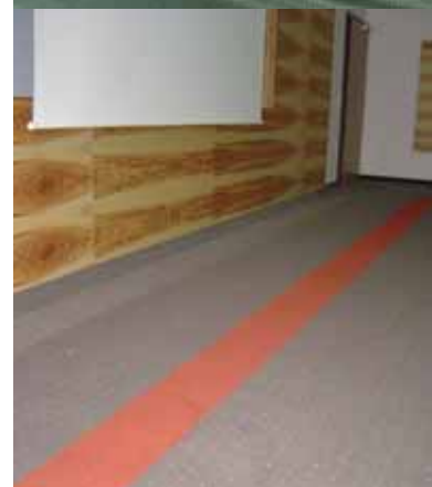
Exemplo de Primer G aplicado antes de aplicar o Ultraplan Eco e do adesivo Rollcoll para a colagem de alcatifa no quarto de hotel - Villa Hotel Castellani - Austria
