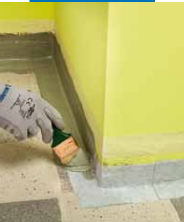
Aplicação de Mapeband SA sobre betonilha
